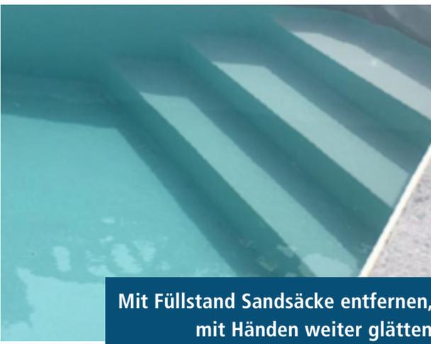
Mit Füllstand Sandsäcke entfernen, mit Händen weiter glätten
