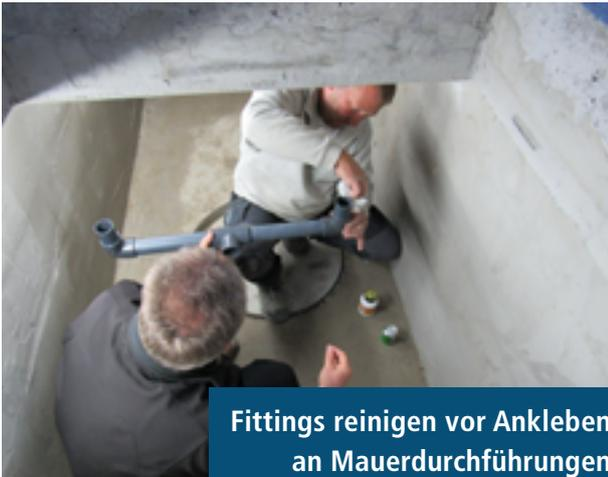
Fittings reinigen vor Ankleben an Mauerdurchführungen
