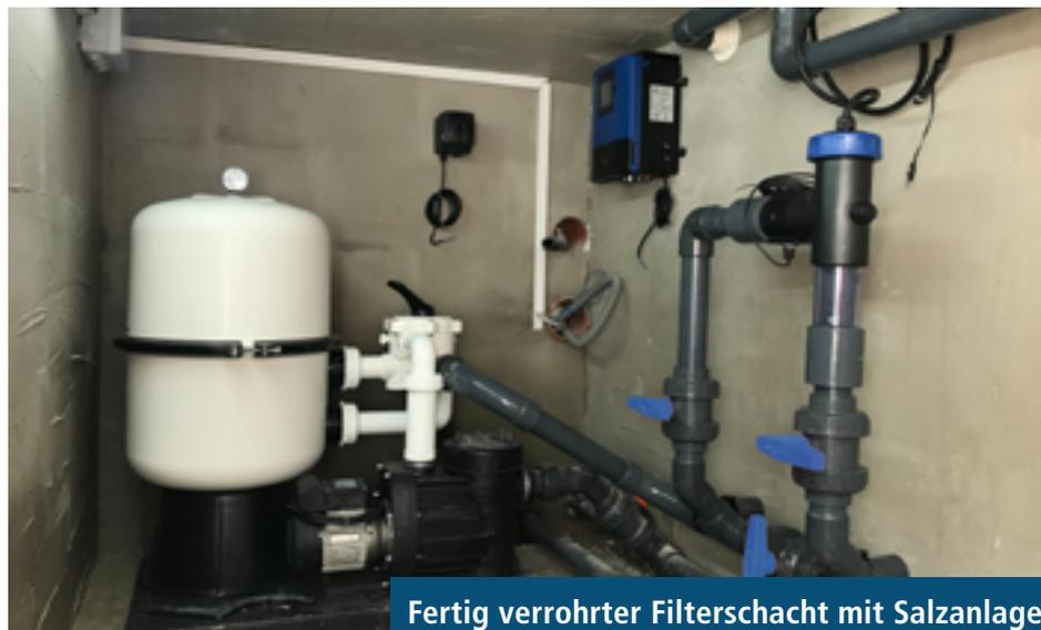
Fertig verrohrter Filterschacht mit Salzanlage
