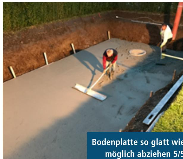
Bodenplatte so glatt wie möglich abziehen 5/5
