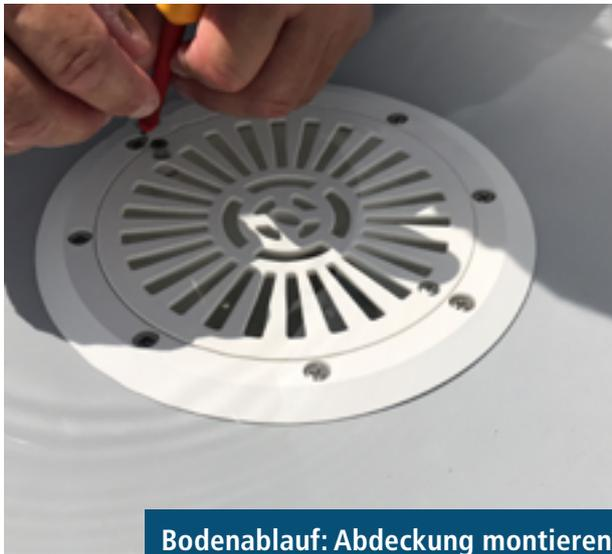
Bodenablauf: Abdeckung montieren
