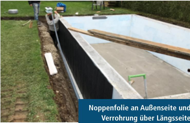
Noppenfolie an Außenseite und Verrohrung über Längsseite
