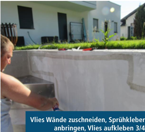
Vlies Wände zuschneiden, Sprühkleber anbringen, Vlies aufkleben 3/4
