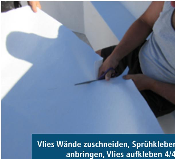
Vlies Wände zuschneiden, Sprühkleber anbringen, Vlies aufkleben 4/4
