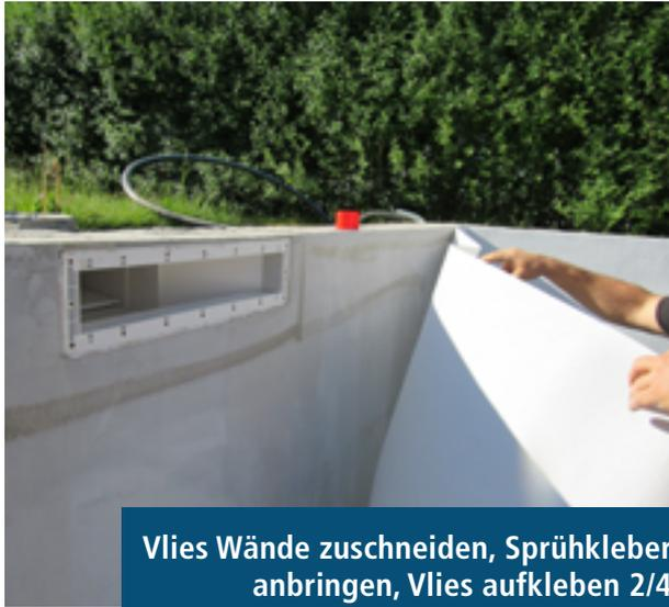
Vlies Wände zuschneiden, Sprühkleber anbringen, Vlies aufkleben 2/4
