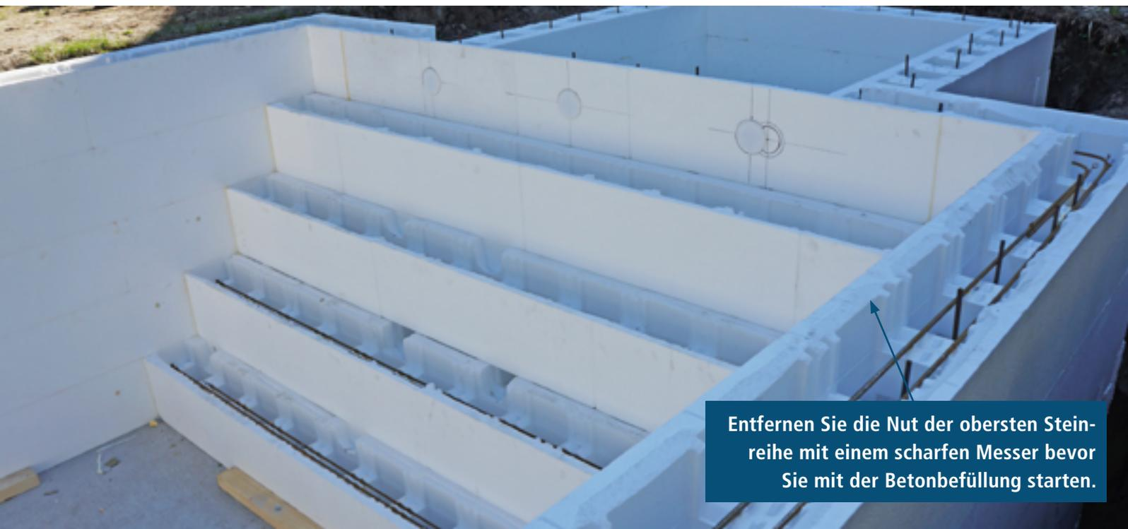
Entfernen Sie die Nut der obersten Steinreihe mit einem scharfen Messer bevor Sie mit der Betonbefüllung starten.
