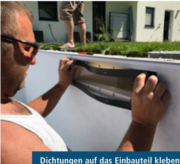
Dichtungen auf das Einbauteil kleben
