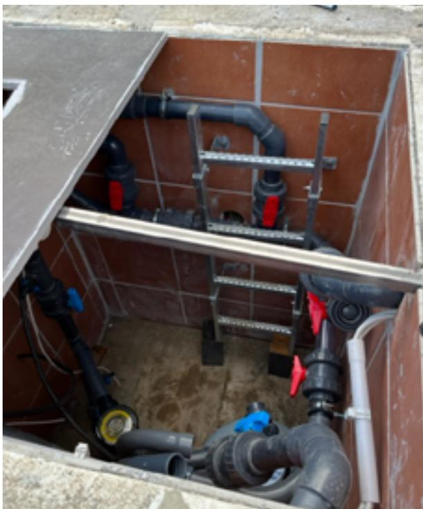
werden. Der jeweilige Abstand der RDS-Durchführungen muss zumindest 20 cm betragen. Sind Rohre im Haus verlegt, muss mit Kondensat gerechnet werden. Hierbei ist sicherzustellen, dass die Rohre jederzeit getauscht werden können.
