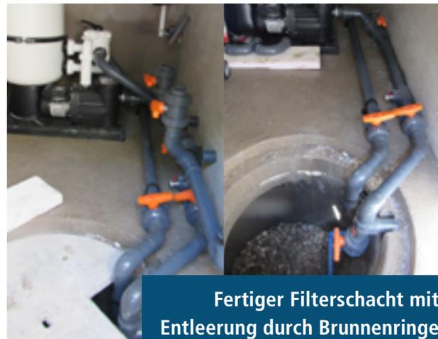
Fertiger Filterschacht mit Entleerung durch Brunnenringe
