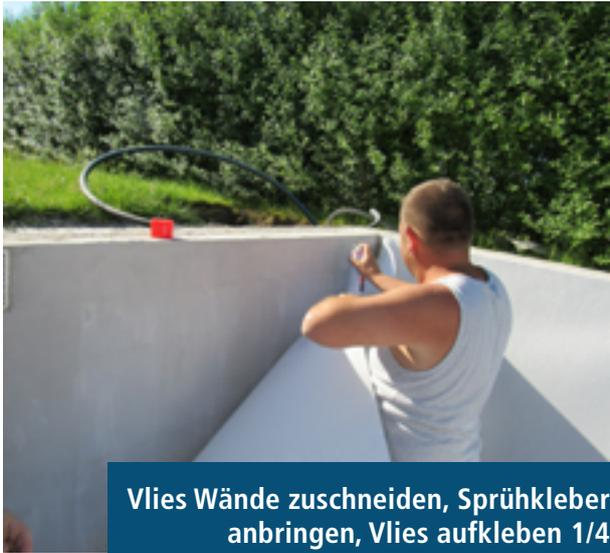
Vlies Wände zuschneiden, Sprühkleber anbringen, Vlies aufkleben 1/4
